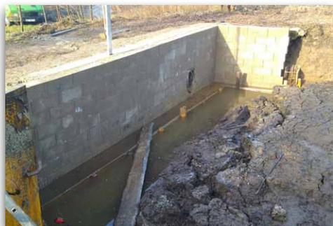
Actuellement, **la digue de l'étang** est en réfection, sa maçonnerie était défectueuse et elle risquait de céder lors d'une crue. La réparation a été prise en charge par la commune et les travaux devraient s'achever bientôt.
